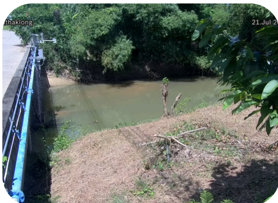
สะพานบ้านท่าคลอง อ.เมือง จ.กระบี่
